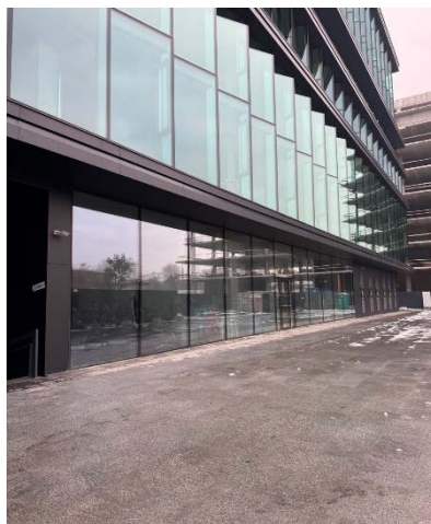
Рис. 3.5. Фасад приміщення майбутнього ІРЦ
