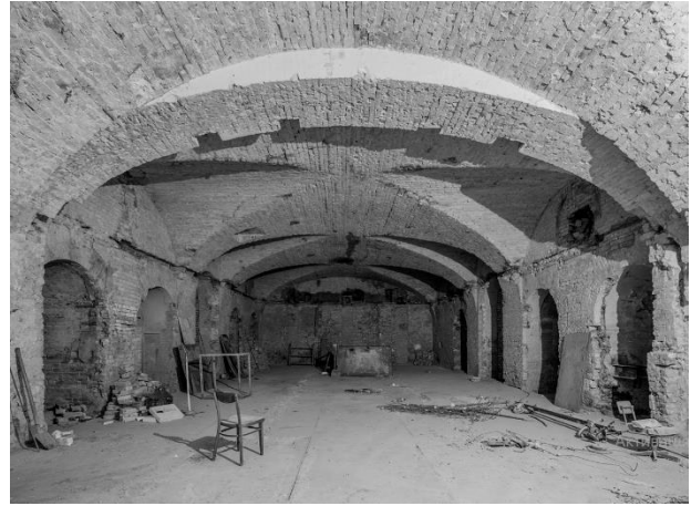
б) після зняття фарби зі стін
