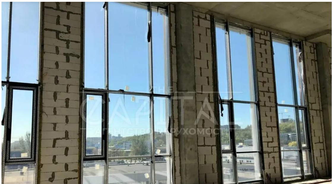
Рис. 2.10 – Поточний стан приміщення
