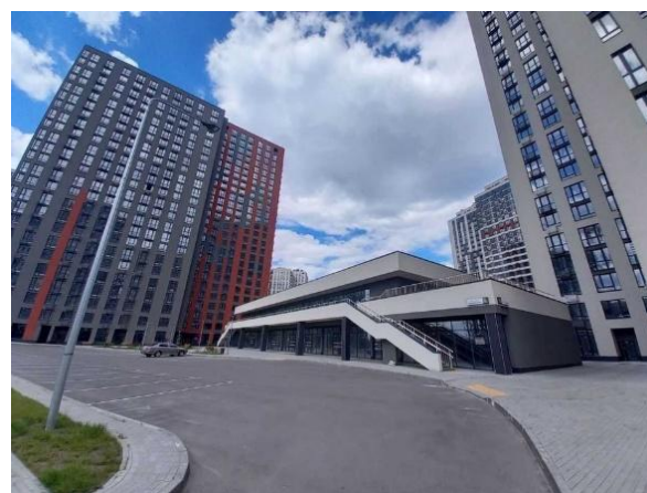
Рис. 2.3, 2.4 Фото фасаду будівлі
