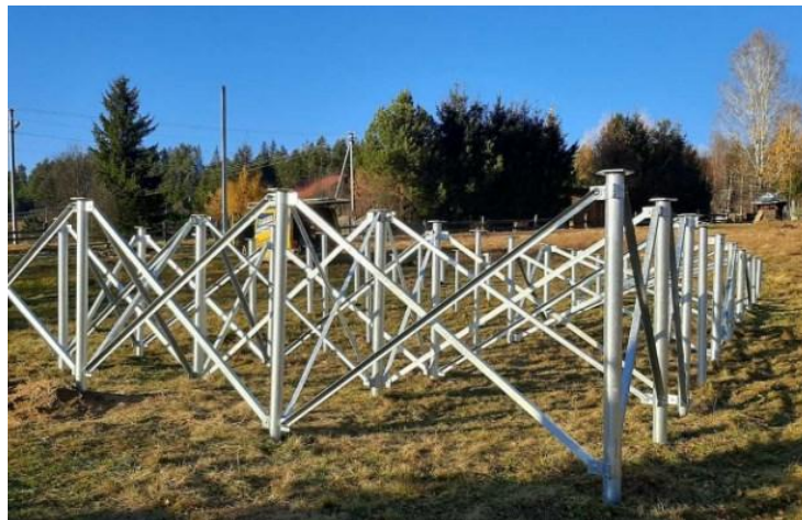
Рис. 2.5. Геошурупи на ділянці під модульний будинок, фото зі сторінки Ефектбуд [49].
