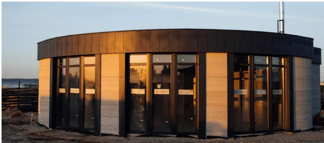
Рис 1.13. Будинок в Ірпені, «надрукований» на 3D принтері.
