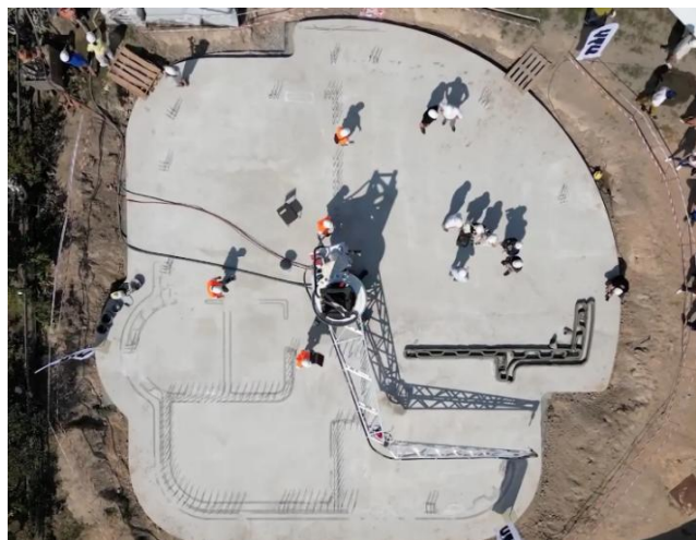
Рис 1.14. Процес друку будинку.
