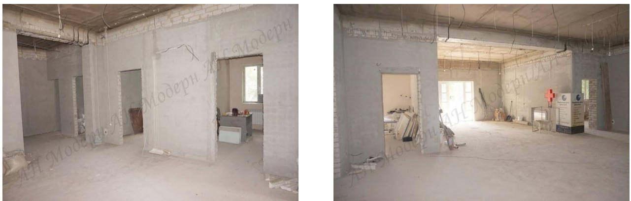
Рис. 2.3. Фото внутрішніх робіт об'єкту.
