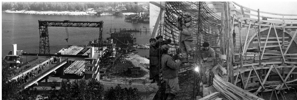
Рис. 3.2 Будівництво лінії Київського метро від станції «Дніпро» на лівий берег, 1963 рік та Спорудження підземного проміжного вестибюля станції «Арсенальна» Київського метрополітену, 28 березня 1958 року
