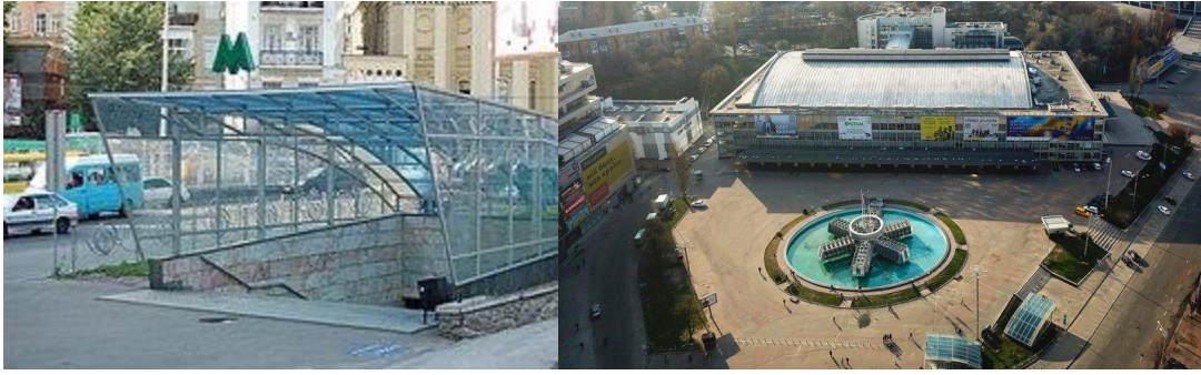
Рис. 3.2.2 Вхід до станції Палац спорту та вид зверху
