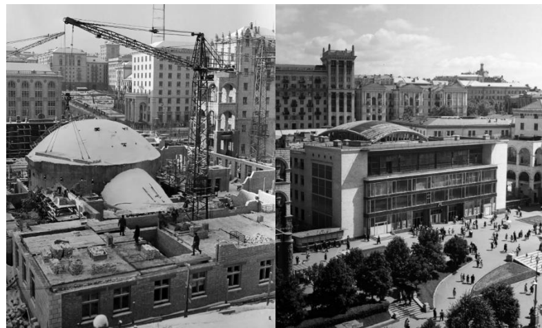
Рис. 3.4 Спорудження наземної станції «Хрещатик» Київського метрополітену, 12 січня 1960 року. Будівля станції «Хрещатик» Київського метрополітену, 1962 рік
