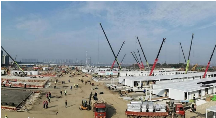
Рис. 2. 10. Лікарня Лейшеньшань під час будівництва
