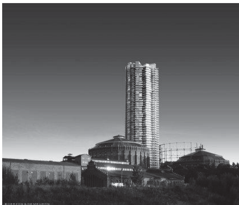
Рис. 2. Житловий комплекс, розміщений у колишньому газосховищі
