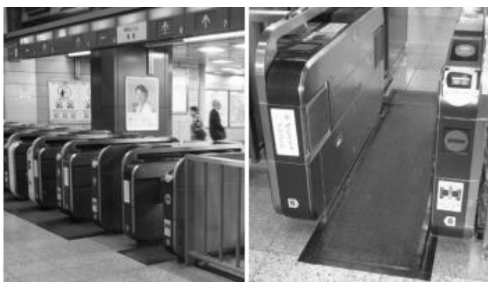
Рис. 1.1 - Система накопичувачів енергії, вмонтованих у настил підлоги на вході станції метро Marunouchi (Токіо)
