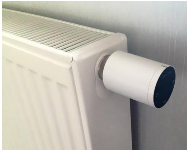
Рисунок 2.10 – Монтаж бездротового радіаторного термостату Tervix Pro
