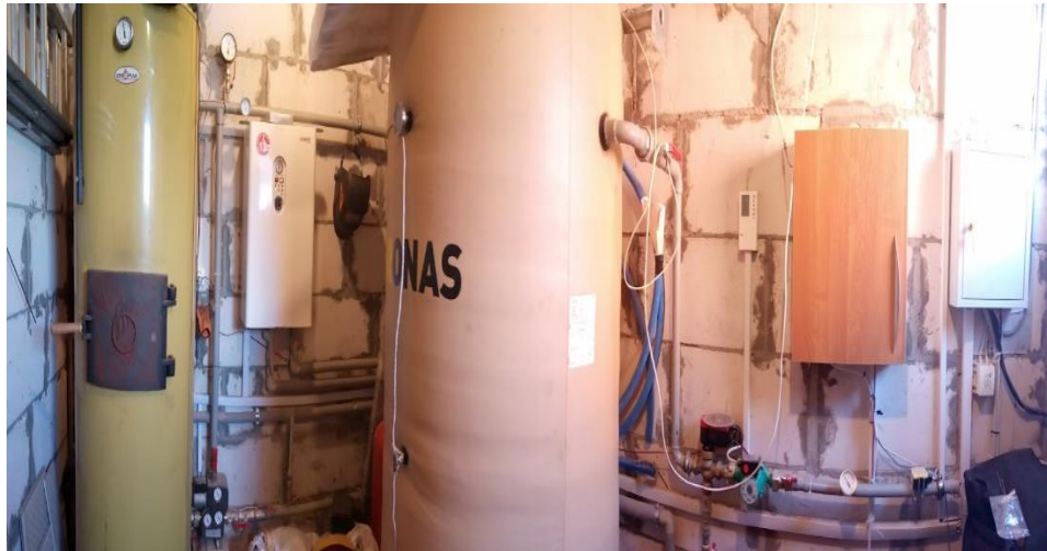
Рис. 3.2 – Котли та агрегати системи опалення
