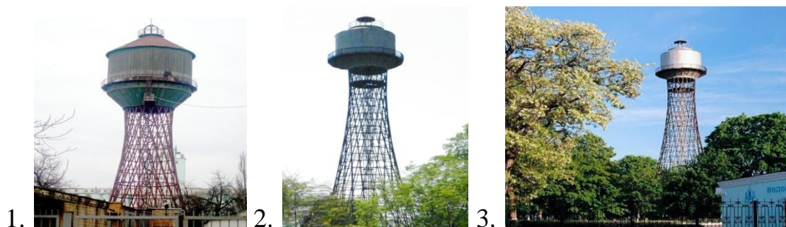
Рис. 6. Вежі В. Шухова в Україні: 1 - водонапірна вежа у м. Біла Церква (1929 р.); 2 - водонапірна вежа у м. Помошна (1934 р.); 3 - водонапірна вежа у м. Черкаси (1914 р.)
