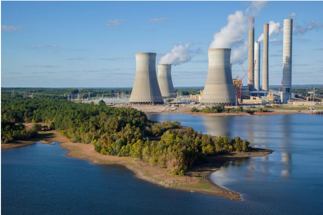
Рис. 7. Електростанція Шерера в Джульетті, штат Джорджія, є найбільшою вугільною електростанцією в США. Вона щодня спалює 34000 тонн вугілля, щороку перекачуючи в атмосферу понад 25 млн тонн вуглекислого газу [1].
